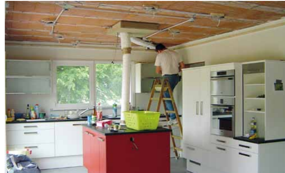
avant : état du chantier à 14 h vorher: Zustand der Baustelle um 14 Uhr before : site at 2:00 p.m.
